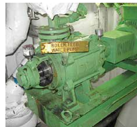
ボイラーのポンプへのシマルーベ30取付例
