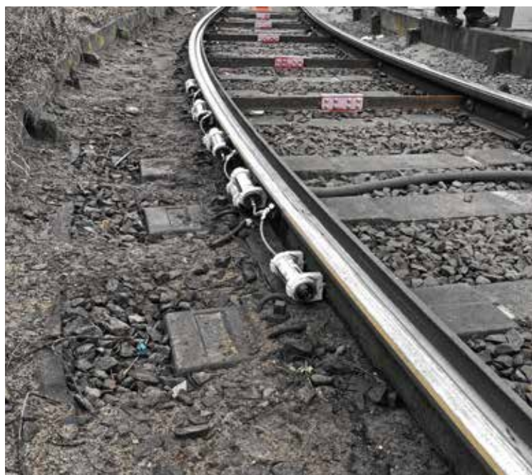
レールへのシマルーベ250取付例。シマルーベによる潤滑できしみを防いでいる例
