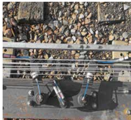
踏切システムへのシマルーベ30とシマルーベ15の取付例
