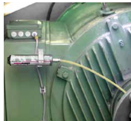
ホースを使用したジェネレーターへのシマルーベ250取付例
