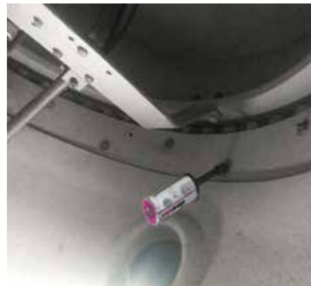
ブレードのベアリングへのシマルーベ125取付例
